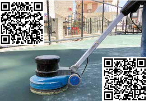
Dolgu katmanının ardından zemine zumpara işlemi yapılmalıdır.
