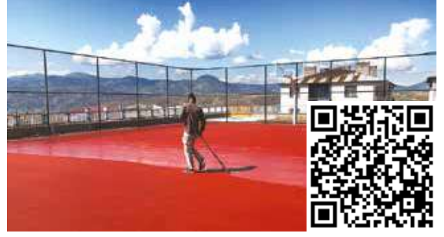
Akrilik zemin kaplaması resimde görüldüğü gibi bu iş için üretilmiş kauçuk gelberi yardımı ile yapılmaktadır.
