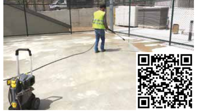
Zemin kaplamasından önce zemin basınçlı yıkama makinesi ile yıkanmaktadır.
