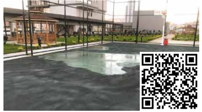
Uygulama yapılacak olan alanda, su toplayan bölgeler var ise, resimde görüldüğü gibi yama uygulaması yapılmaktadır. Yapılan uygulamada özel akrilik tamir harcı kullanılmaktadır.
